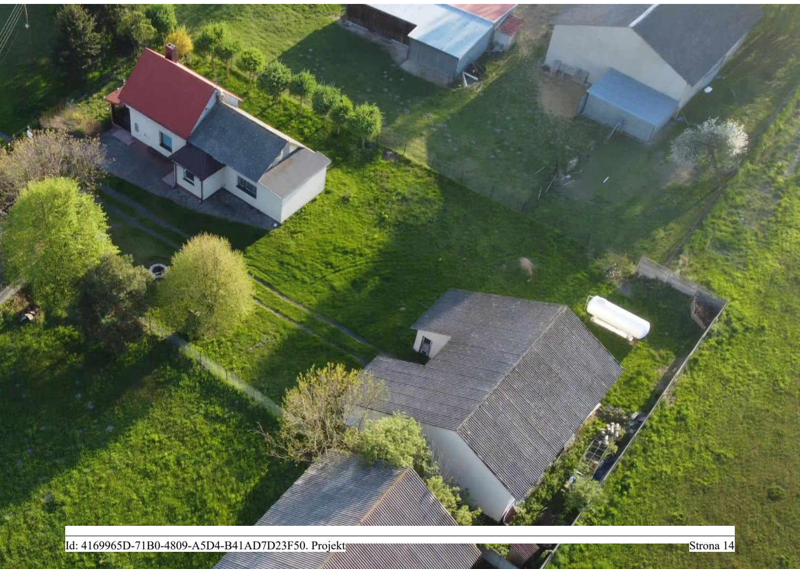
Fot. 1. Wykorzystanie wyrobów azbestowych jako pokrycia dachowe.
